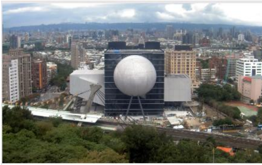
臺北藝術中心接續工程 (第一標)帷幕外牆工程
