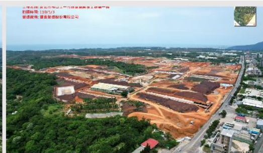
新北市林口工一市地重劃 開發工程第一標
