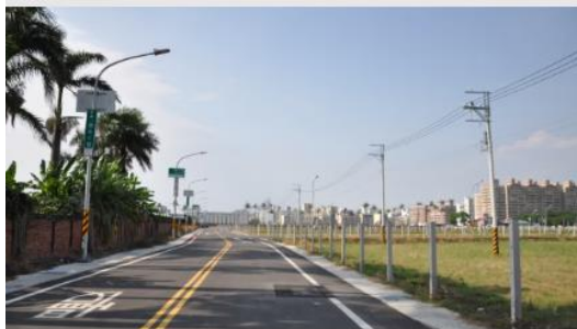
臺南市南台南站副都一期 區段徵收工程(南工區)
