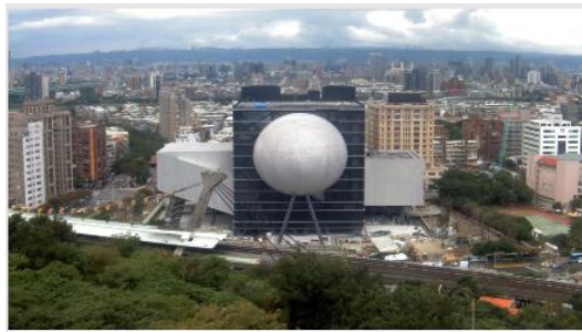
臺北藝術中心接續工程 (第一標)帷幕外牆工程
