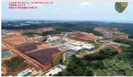
新北市林口工一市地重劃 開發工程第二標
