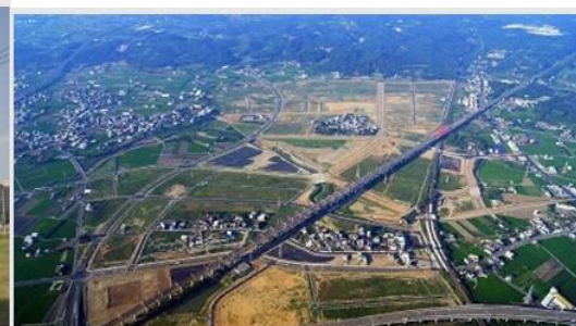
高速鐵路苗栗車站特定區 公共設施統包工程
