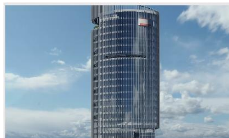
彰化銀行建成大樓興建工程
