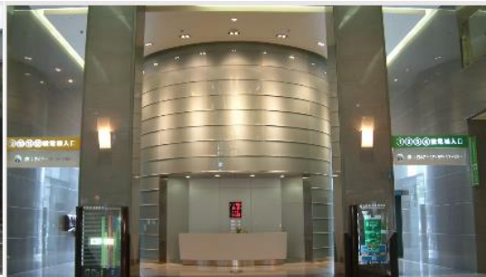
台北縣政府大樓裝修工程
